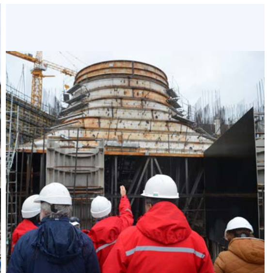
右：豪尔赫·塞佩尼大坝的一个涡轮机进气管图。
