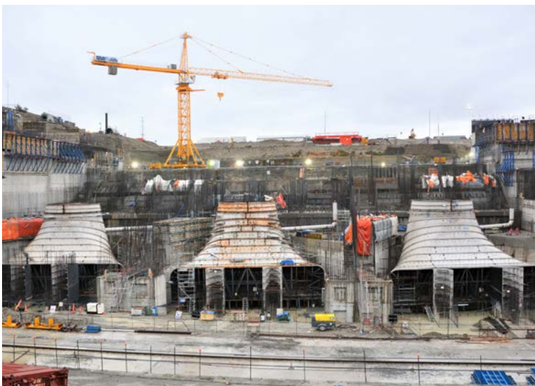
左：豪尔赫·塞佩尼大坝：三个涡轮机的进气管图。
