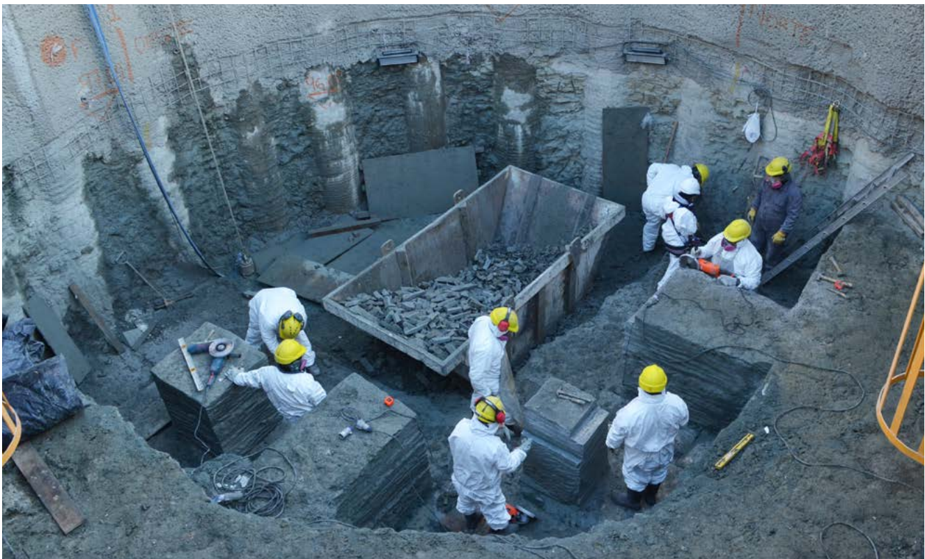
即将建成的内斯托·基什内尔大坝的勘探井中的作业人员
